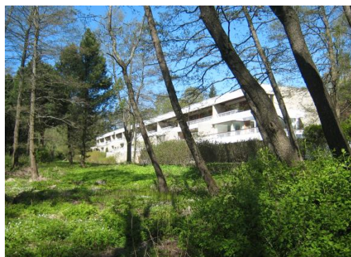
Tontille 30214/6 on voitu toteuttaa puistoalueeseen avautuvat etelän puoleiset parvekkeet.
