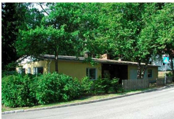
Maununnevan seurakuntakoti Juoksuhaudantie 37, 00430 HELSINKI
