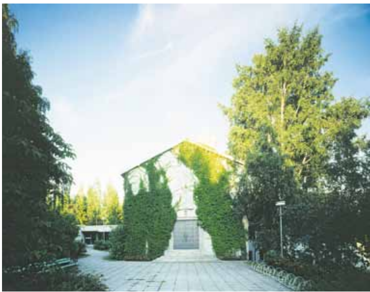
Puut ja villiviini kätkivät Pakilan kirkon ja sen siipirakennuksen suojaansa 90-luvulla
