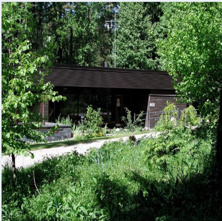
toimisto- ja uurnaluovutushuone
